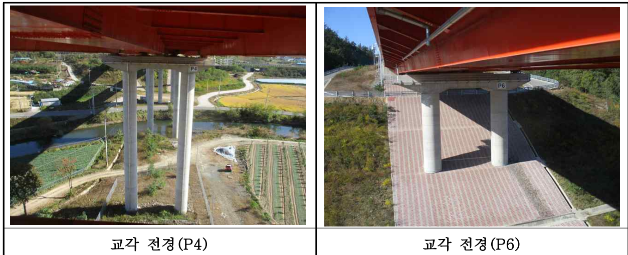
【사진 29.3.10】 교각 전경
