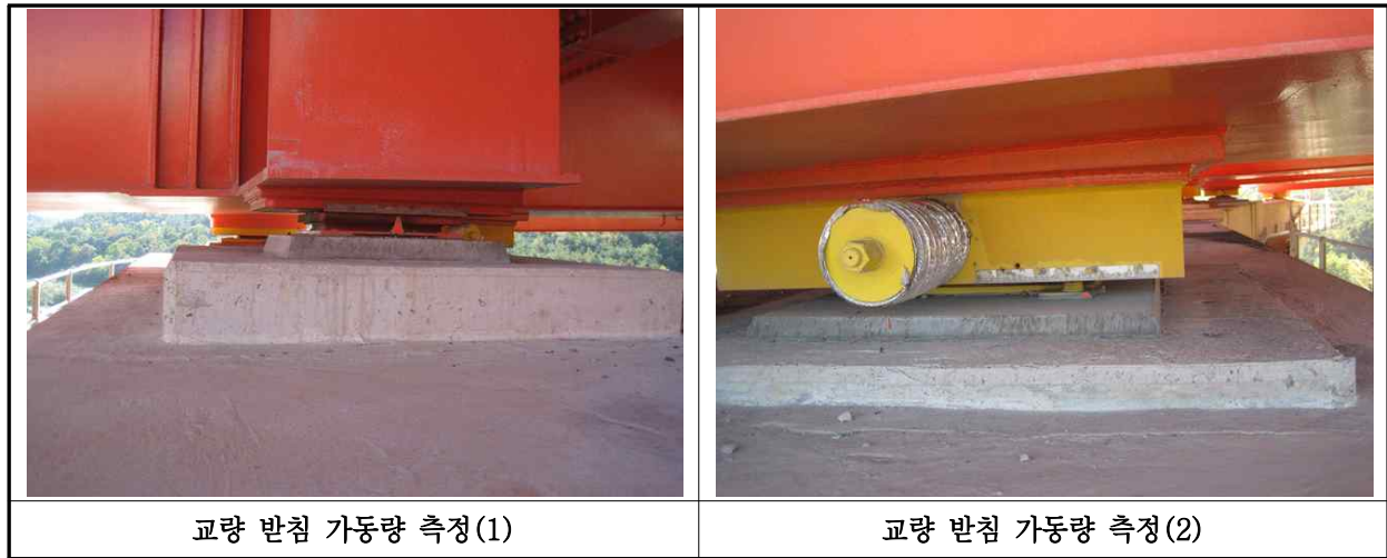
【사진 29.3.15】 교량받침 이동량 측정
