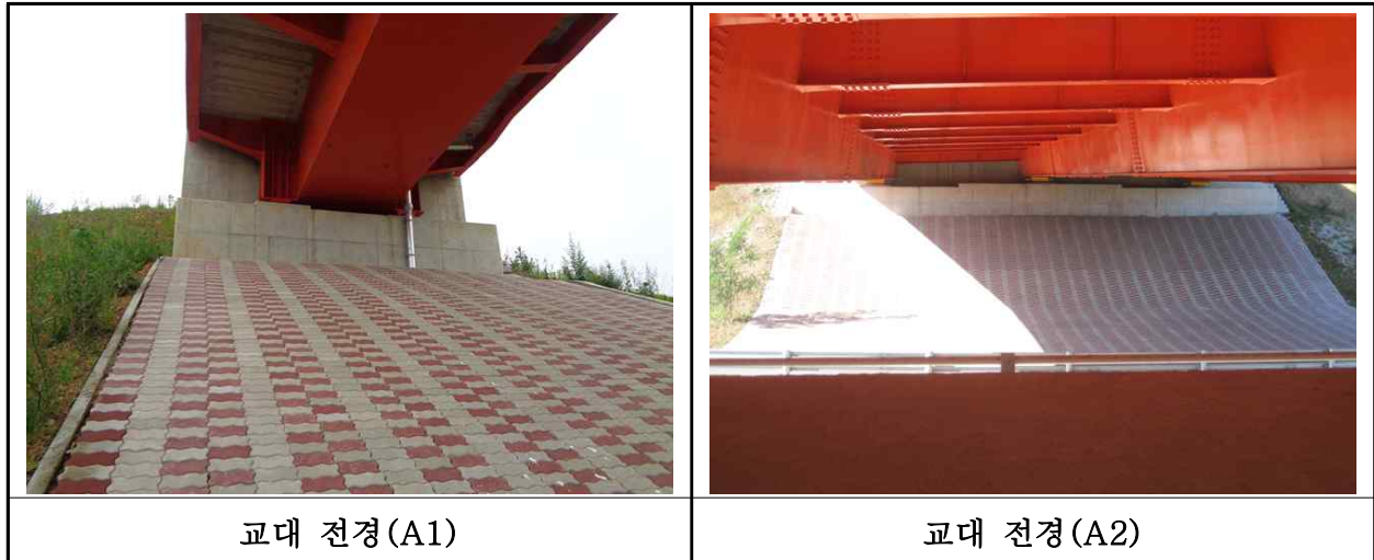
【사진 29.3.8】 교대 전경
