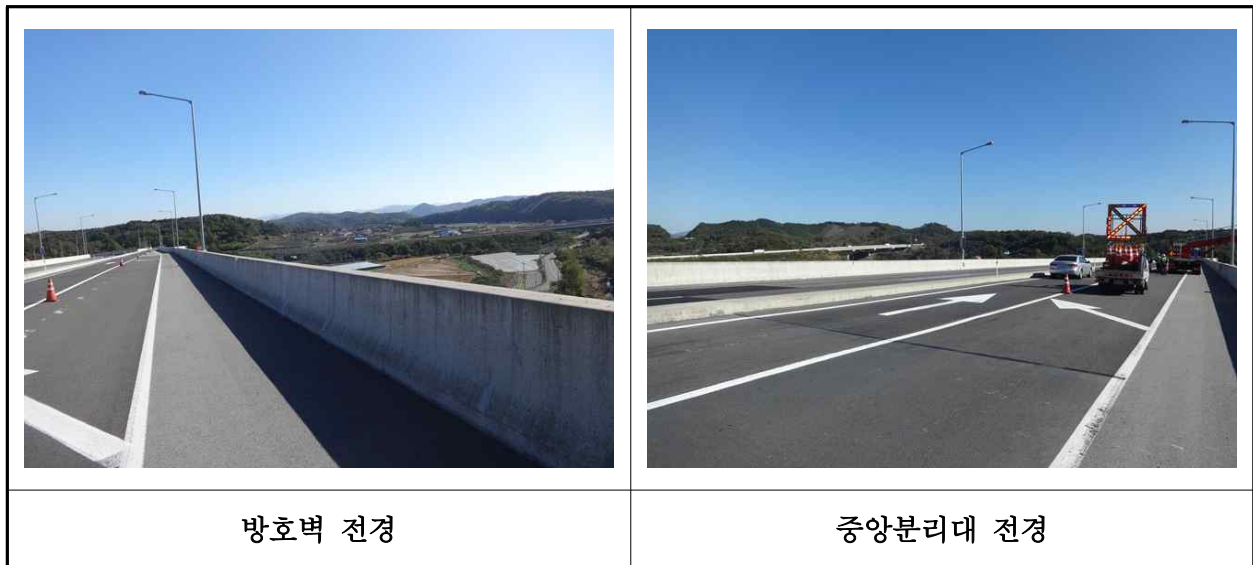
【사진 29.3.23】 방호벽 및 중앙분리대 전경
