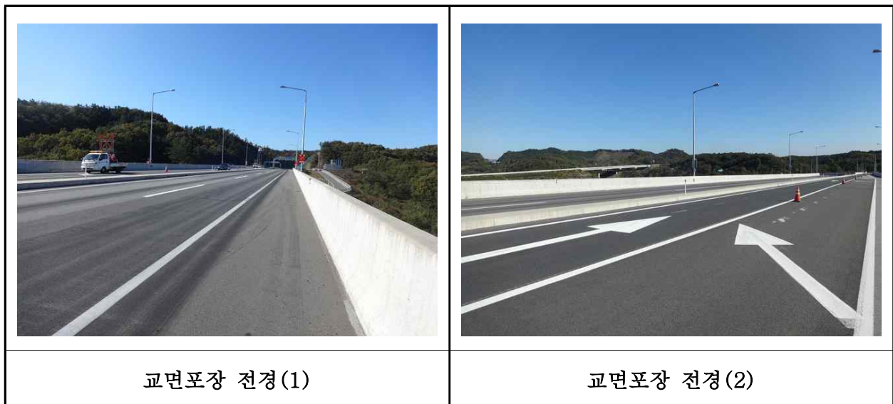
【사진 29.3.19】 교면포장 전경
