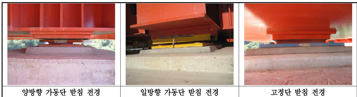
【사진 29.3.12】 교량받침 전경
