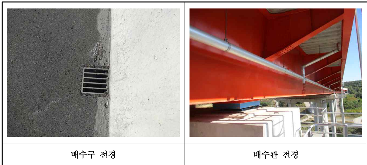
【사진 29.3.21】 배수시설 전경
