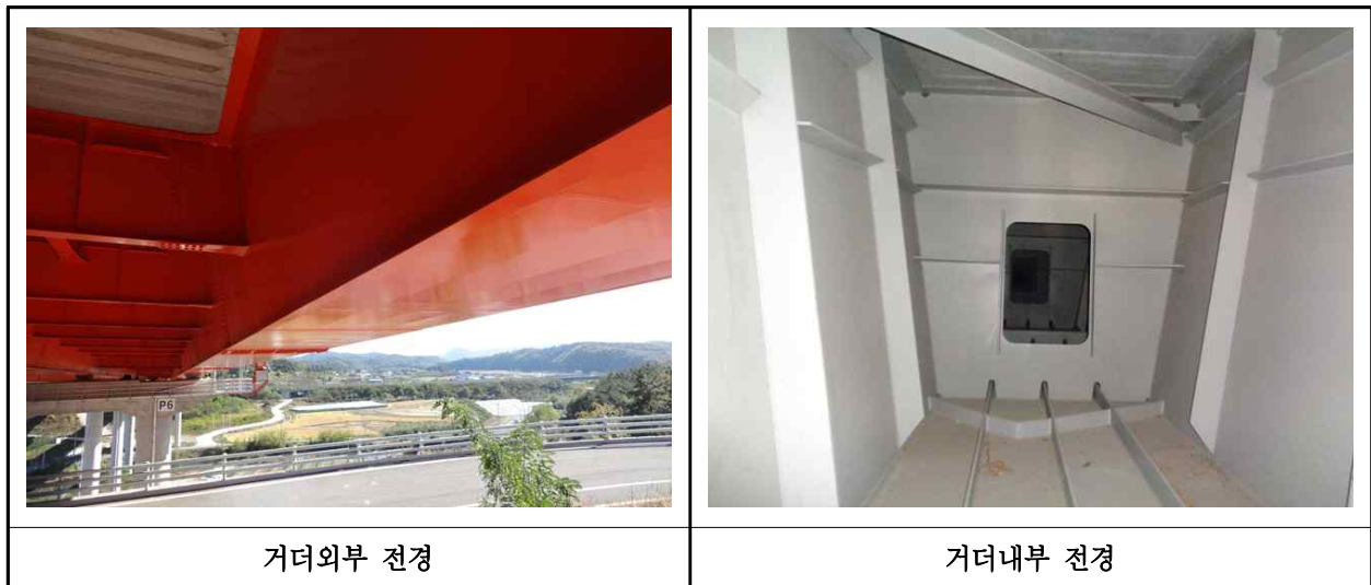
【사진 29.3.4】 거더 전경
