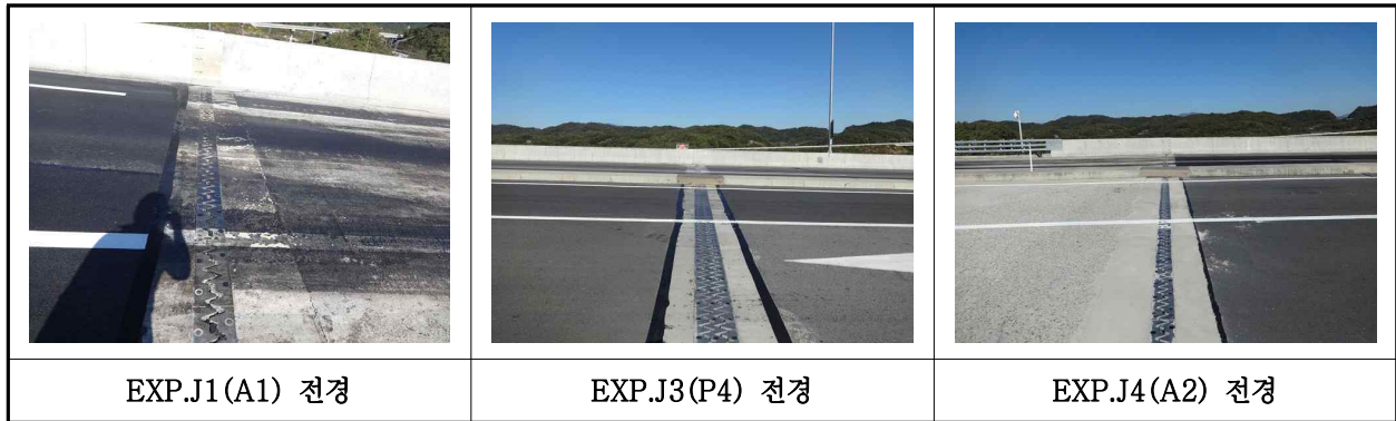
【사진 29.3.16】 신축이음장치 전경
